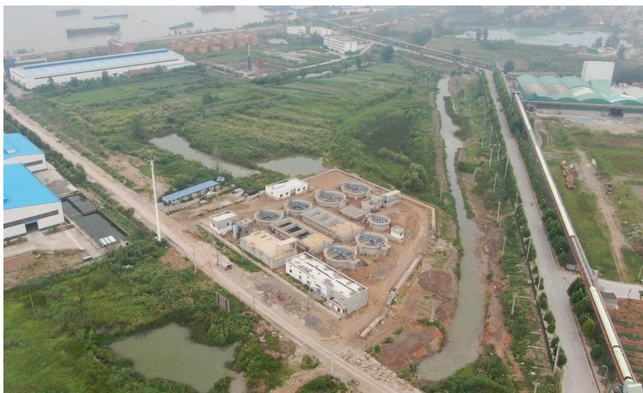
图 5.2-2 郝矾污水处理厂建设现场
