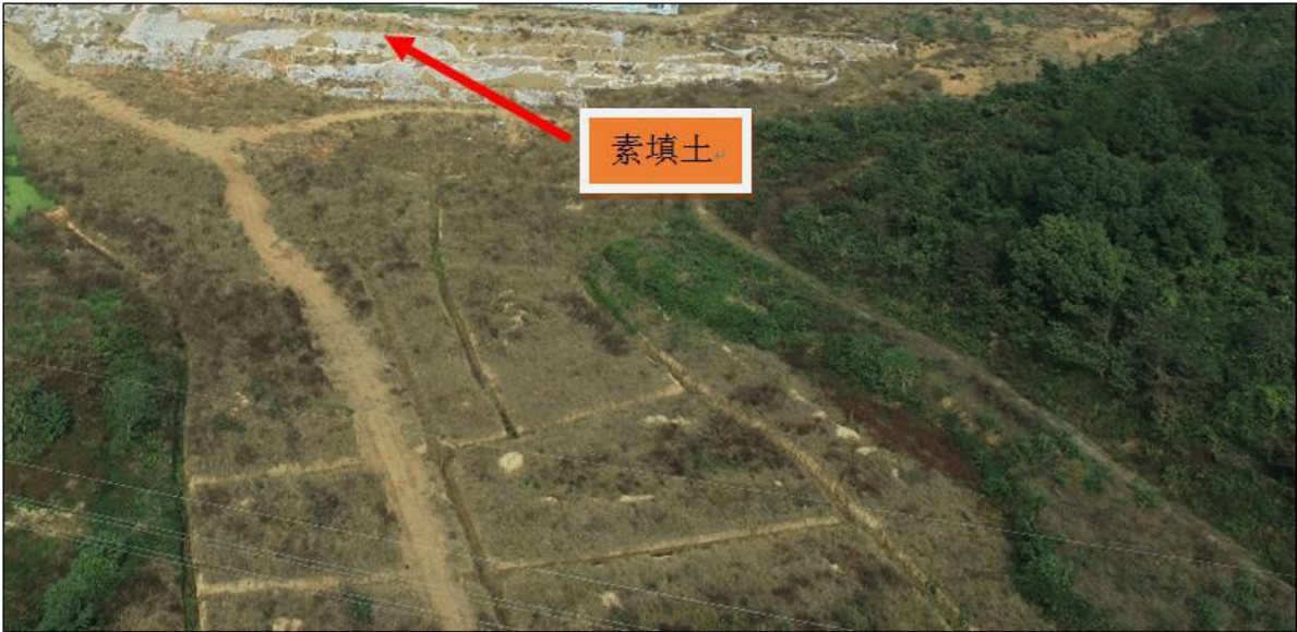
图 5-6-10 素填土分布区域及现场管沟排水
