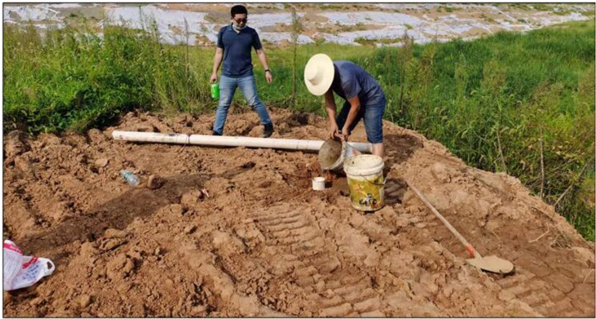
图 5-6-13 注水试验现场工作照片 (SK2)
