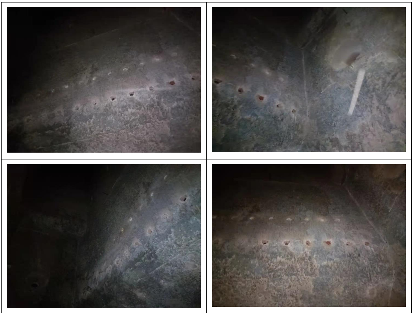
图 7-2-3 漳州南部项目运行 2 年后炉膛内部耐火材料照片
