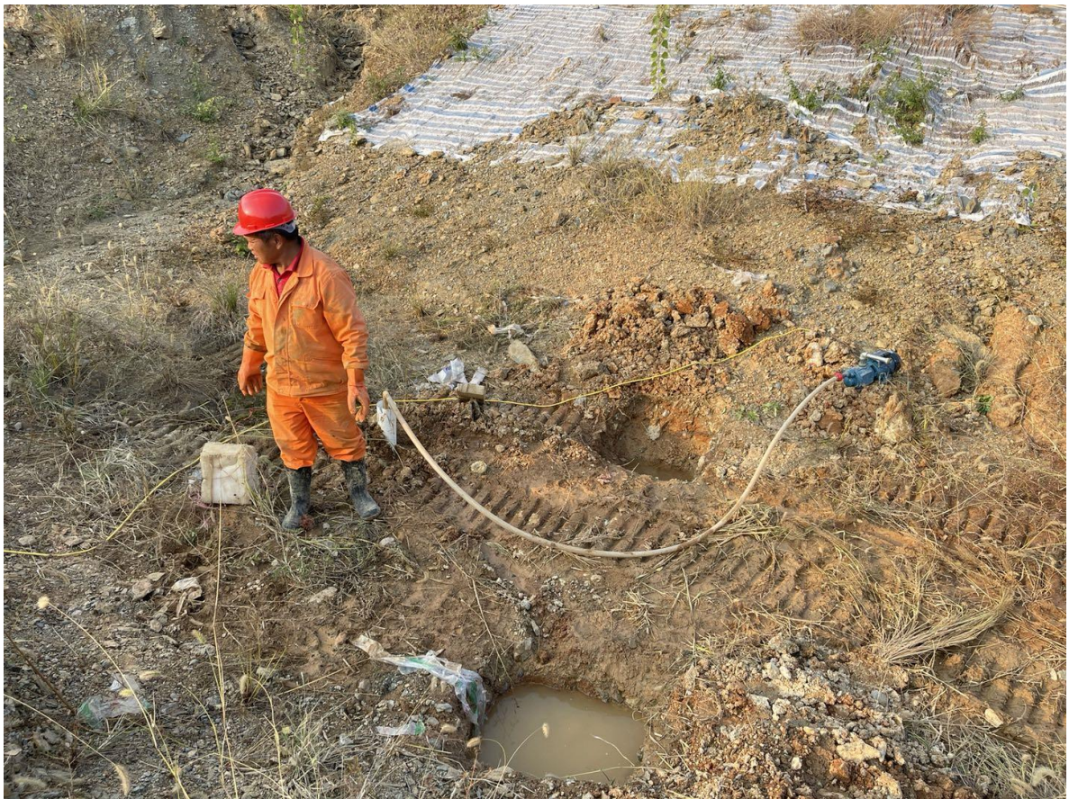
图 5-6-11 素填土层抽水试验
