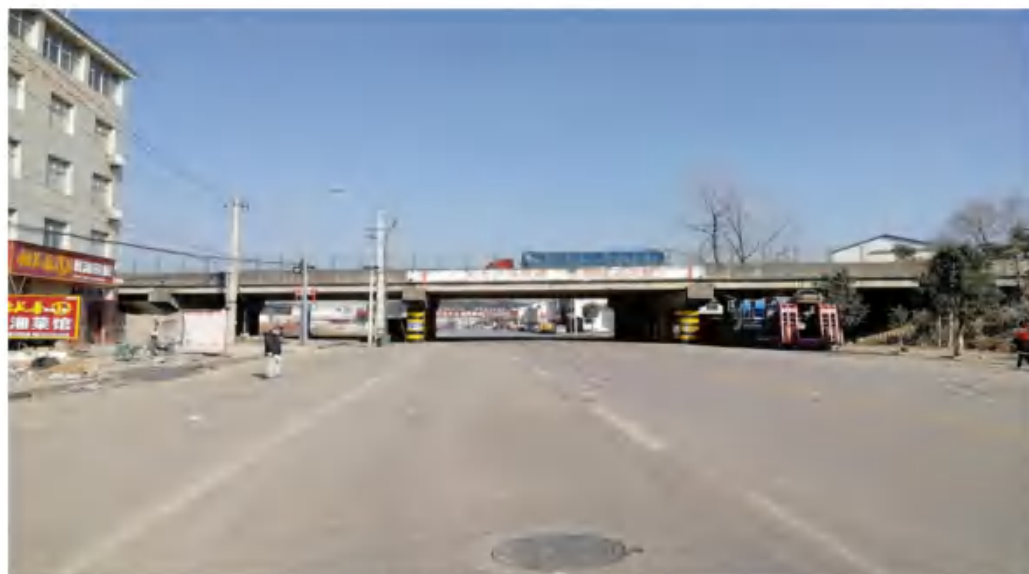
现状大广高速跨线桥
