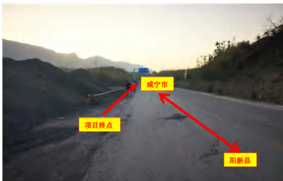
项目终点实景图
