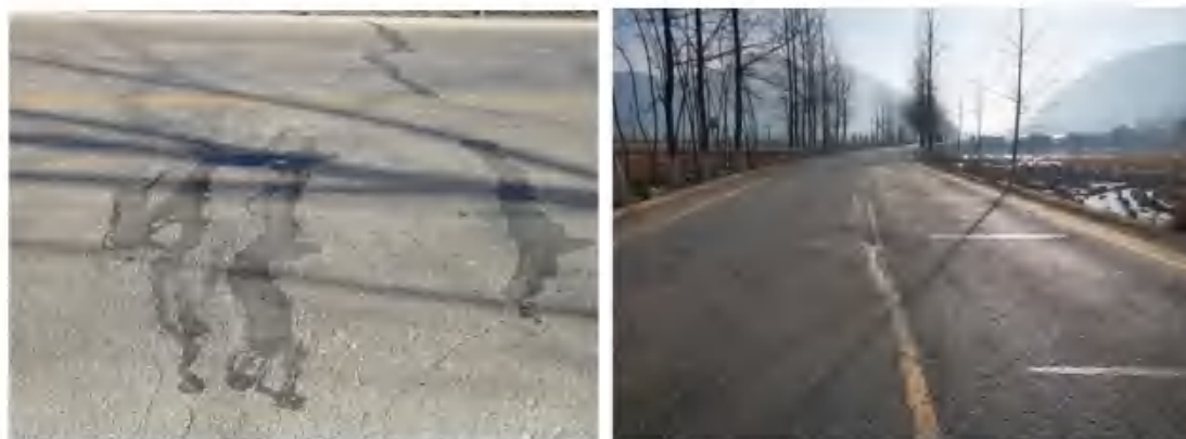
现状 G351 三溪至毛坪段路面状况
