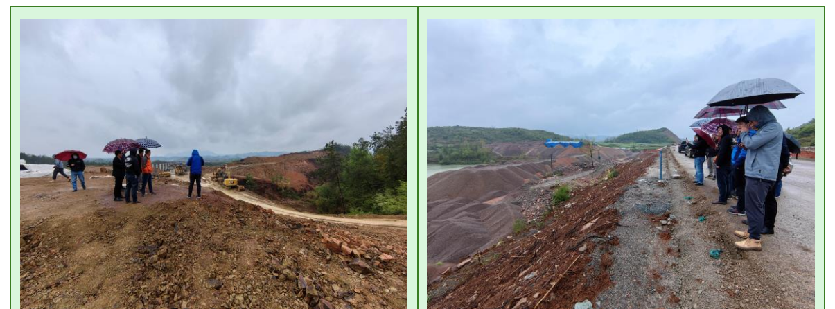
武阳高速阳新段取弃土场监督检查
